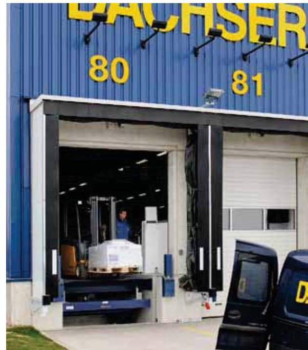
Liftvelleral on teleskoopkeelega laadimissilla ja käärtöstuki kombinatsioon
