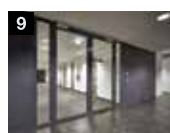
Полностью остекленные трубчатые рамные конструкции
