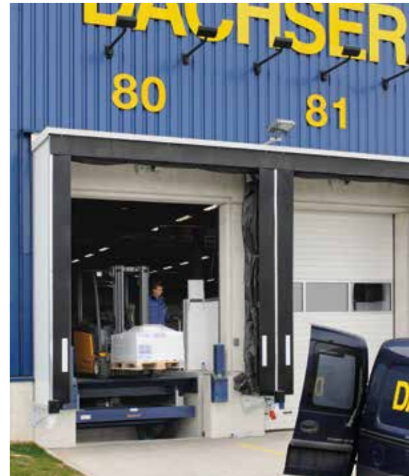
Подъемная платформа представляет собой комбинацию перегрузочного моста с выдвижной аппарелью и платформы ножничного типа
